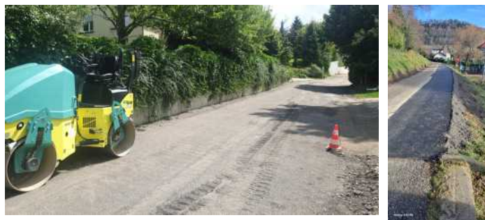
Rue de l'Étang et Rue Saint-Bernard : réfection de la voirie
