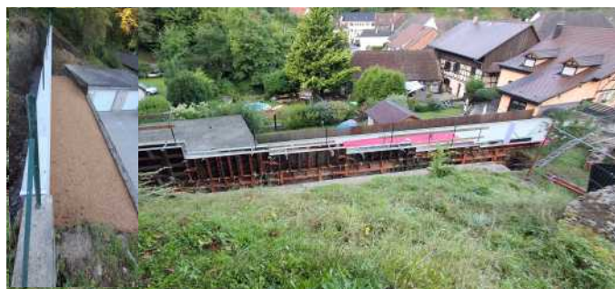
Monument aux Morts : consolidation du mur de soutènement
